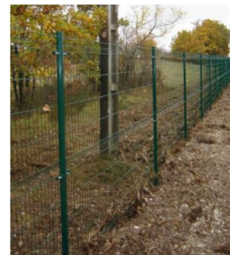
Figure 43: Exemple de clôture installé sur les parcs photovoltaïques
