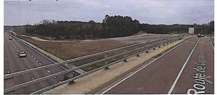
et depuis le pont sur l'A63
