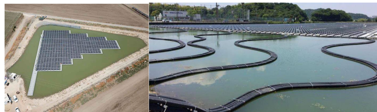
Figure 6 : Exemple de pontons et de câbles utilisés sur les centrales photovoltaïques flottantes (Source : C&T )
