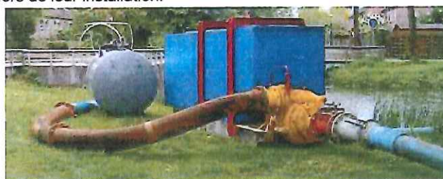
Figure 10 : Exemple de pompe de relevage auxiliaire « booster »
