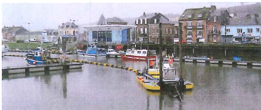
Figure 5 : Illustration d'un dragage portuaire à l'aide d'une DAS 10 pouces et conduite flottante
